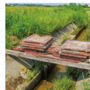
魚道の堰板を外し、来年まで保管します(せせらぎの郷 須原)
