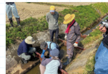
約200mの水路に等間隔で樹脂製のパネルをはめます(せせらぎの郷 須原)
