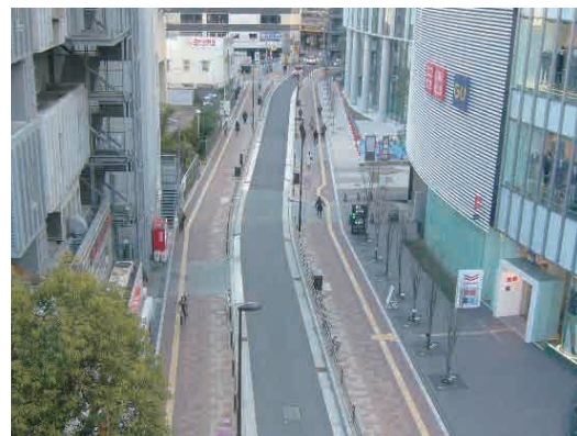
茶屋町地区内区画道路1号線(施工後)
