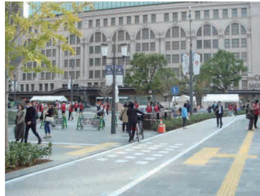
御堂筋道路空間再編工事(なんば駅周辺)
