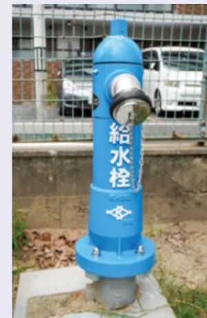
災害時の応急給水栓。ホースをつなぎマンホールトイレに給水もできる
