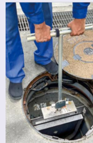
排水用の仕切り弁。引き上げると水が流れる仕組み
