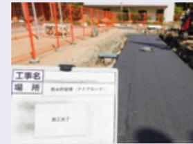
マンホールトイレの水源に活用される「雨水貯留槽」
