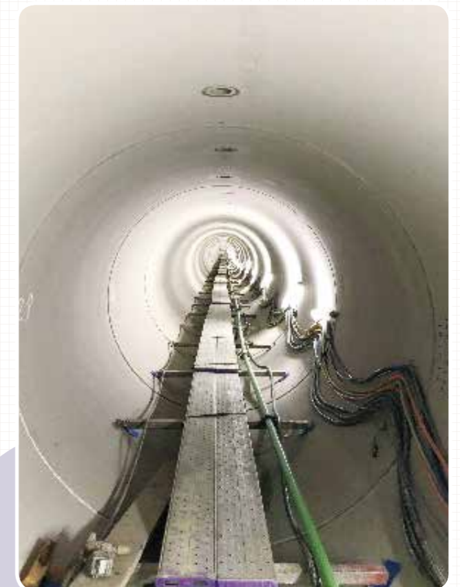
φ2400貯留管推進工法
