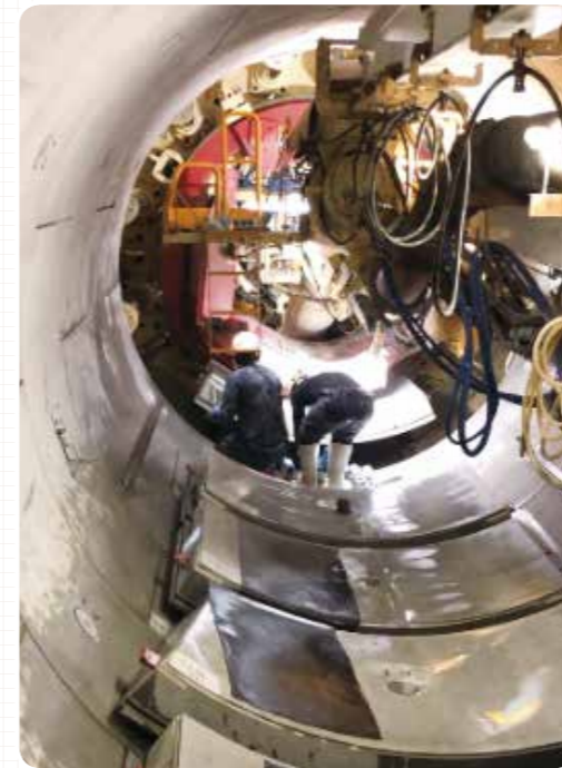
八王寺川バイパス管シールド工法
