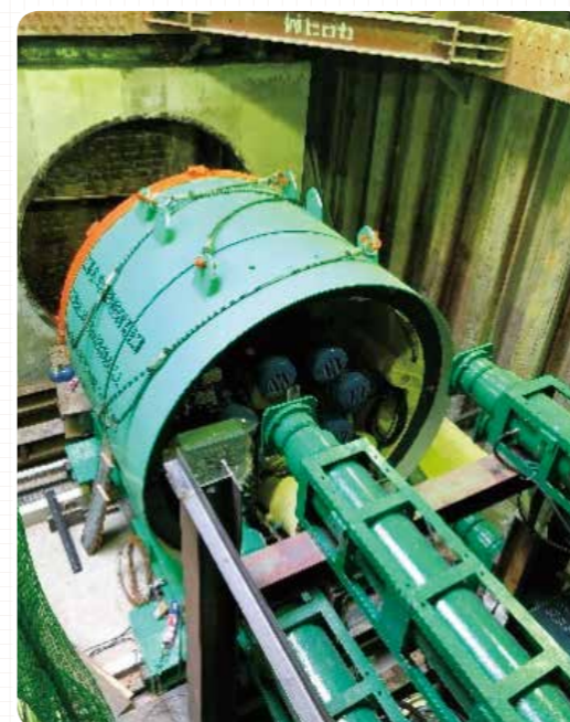
φ2400貯留管推進工法
