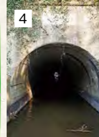
4 切山隧道は昭和に入ってコンクリートで補修されましたが、内部には400年前の姿が残されています(写真提供:赤穂市教育委員会)
