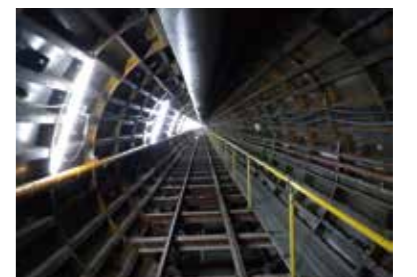
写真-3 中の島・片山工区一次覆工
