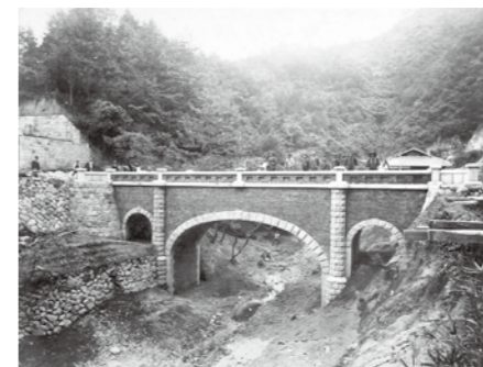
レンガ造りのアーチ形状が美しい砂子橋(完成当時)。
