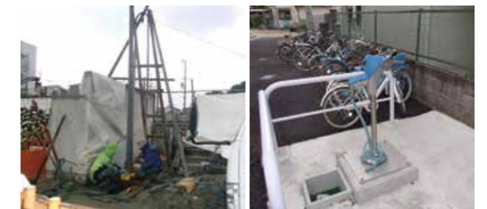
水源設備設置
