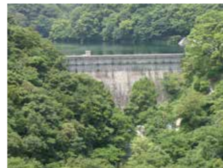
2001年から耐震補強のほか、水を抜いて堆積した土砂を取り除く工事などが実施された。
