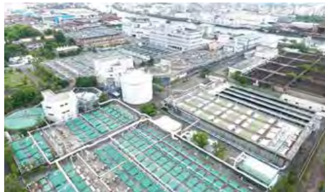
上空から見た津守下水処理場
