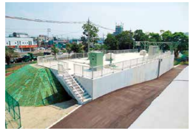
雨水滞水池(下野町ポンプ場)
