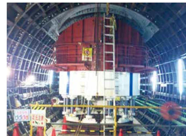
上向きシールド機坑内設置状況
