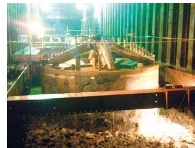
上向きシールド地上部到達状況
