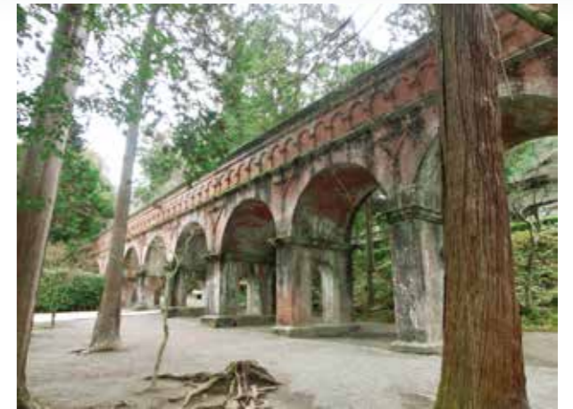
南禅寺水路閣。橋の上を水が流れています
