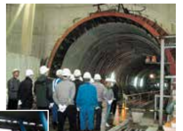
シールド工事現場視察
