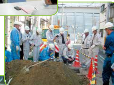
取付管敷設工事見学
