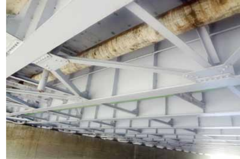
五条大橋の裏側を通る本願寺水道
