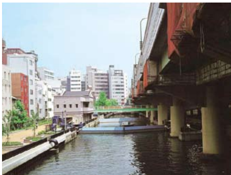
東横堀川水門
