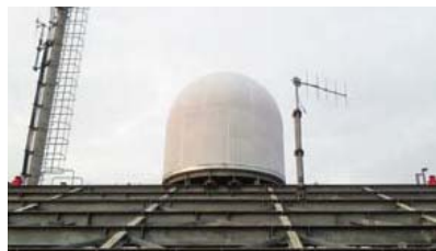
更新後のレドーム(内部に設置されたレーダーアンテナを保護するための覆い)
