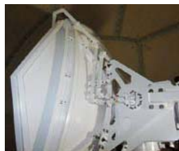
大阪市港区弁天町オーク200の屋上に設置されたレーダーアンテナ
