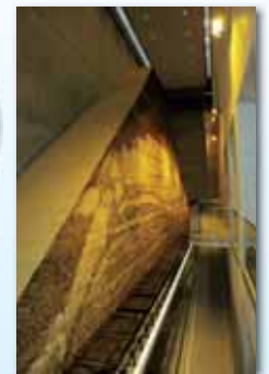
移築された北堤断面
