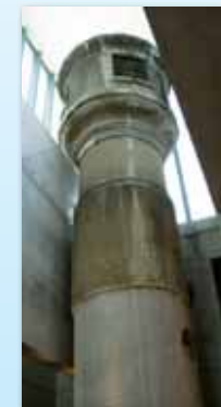
移築された旧中樋取水塔
