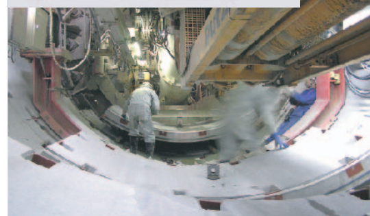
黙々と土塊をほぐす穴掘りくんを内側から撮影。写真奥がトンネルの先端になる。轟音、閉塞感、暑さのなかで作業は続く。
