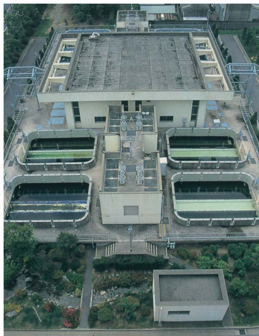
急速ろ過施設(平野下水処理場)
