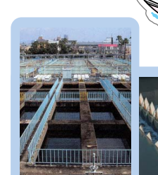
■沈澄池(最終沈殿池) よごれを食べた微生物と水 にわける。
