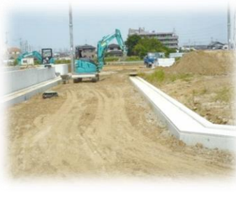
工事監理支援 (土地区画整理区域内)
