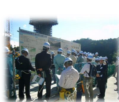
橋梁現場視察 (関西道路研究会)
