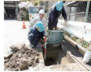
西淀川区中島工業団地内道路
