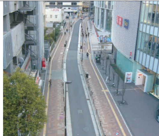
茶屋町地区内区画道路1号線(施工後)
