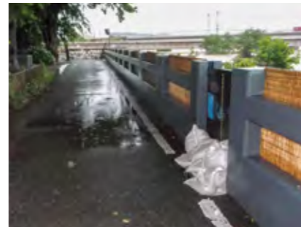
畳と堰板、土のうを実際に設置しました
