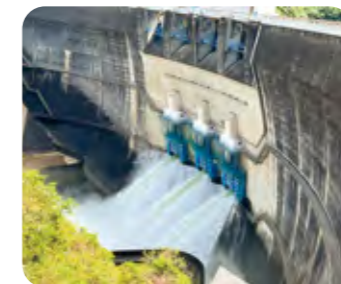
◀コンジットゲート(通常の放流コントロールを行うゲート)を至近距離で見学できます
