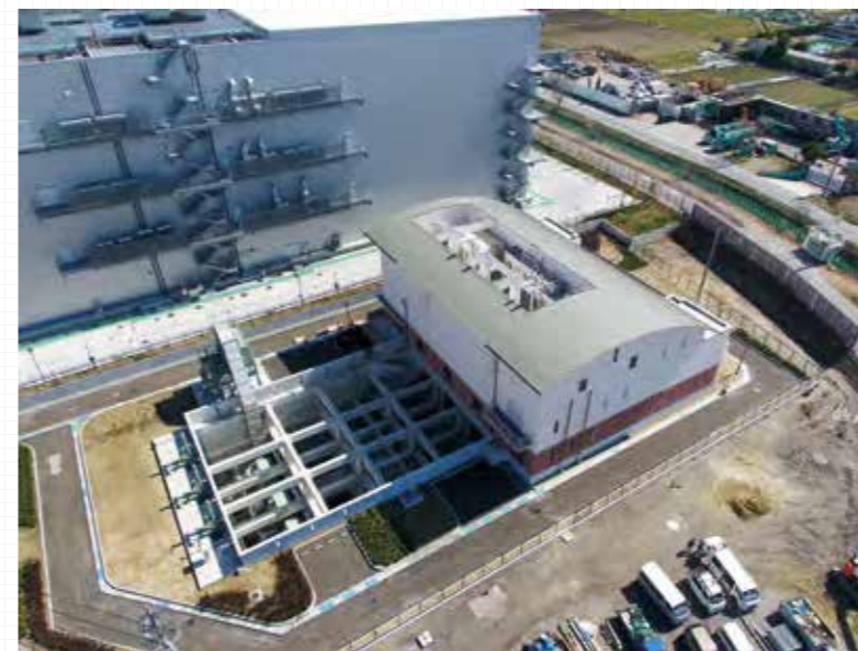
高宮ポンプ場
