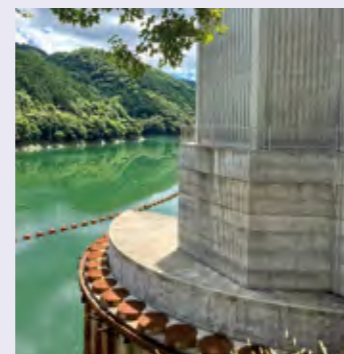
トンネル流入部は、鳳凰湖と称されるダム湖との調和に配慮した建屋
