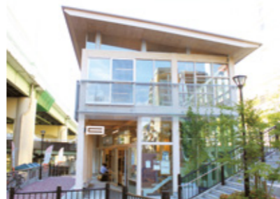
自然光をふんだんに採り入れた2階建て。目の前に東横堀川、その真上を阪神高速道路が走っている
